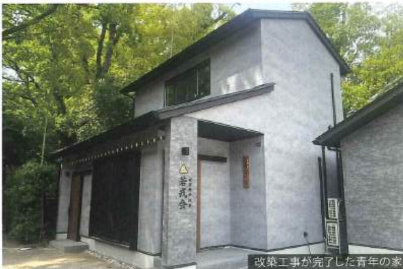
改築工事が完了した青年の家
