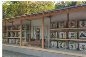
改修工事が完了した飾樽舎
