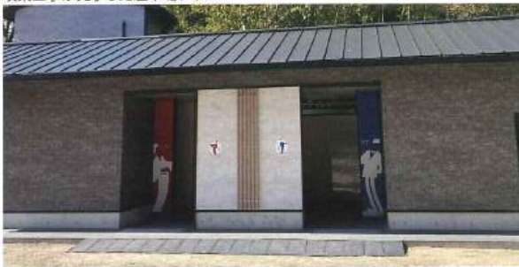
改築工事が完了した駐車場トイレ
