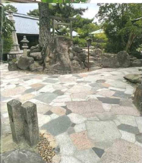
補修工事が完了した神池参道
