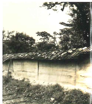
大空襲あと昭和25年工事前の大練塀南面東部
