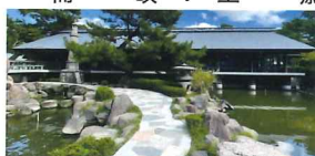
完了した神池参道補修
