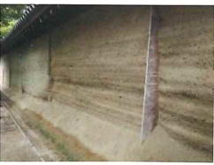
令和3年修繕工事前
