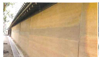
令和3年修繕工事後
