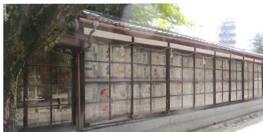
改修予定の飾り樽舎
