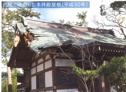
台風で破損した本拝殿屋根(平成30年)
