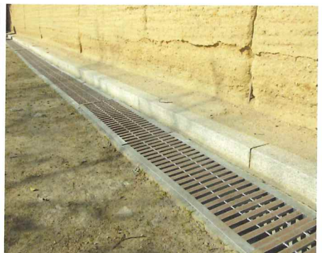
整備された排水路
