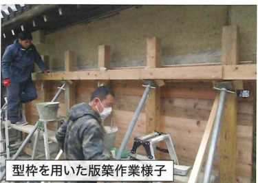
型枠を用いた版築部分
