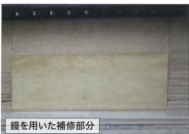
左 型枠を用いた版築 右 鏝を用いた補修
