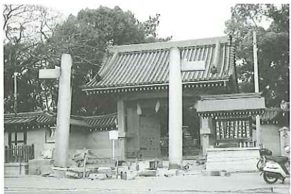
震災で崩れた旧大鳥居
